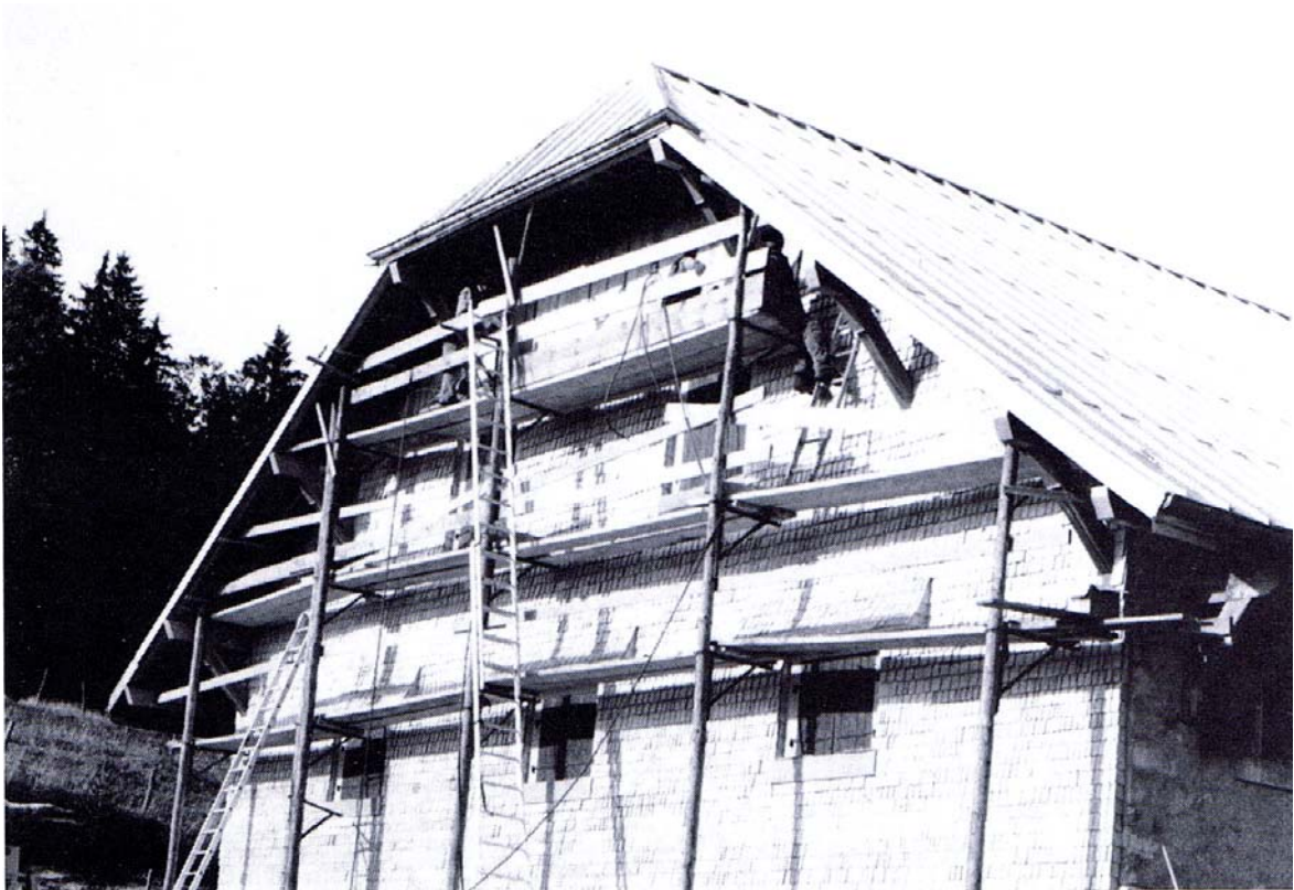
Au chalet de la Grande Tête : tavillonnage de la façade ouest (septembre 1990).
